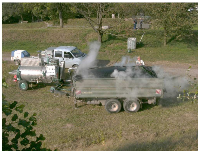
Figure 7 : Pour de grandes quantités de terre décapée, on peut équiper une remorque d'un dispositif injecteur de vapeur (photo : Möschle Seifert).
